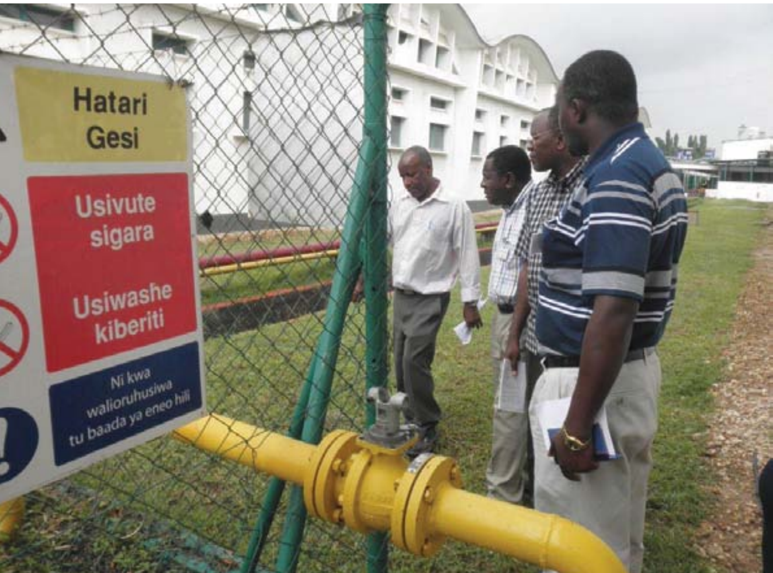
Mkurugenzi wa Bodi ya EWURA, Bw. Nicholas Mwanji (wa pili toka kushoto), Mkurugenzi wa EWURA wa Gesi Asilia, Mhandisi Charles Omujuni, (wa tatu kulia) na Meneja wa EWURA wa Usambazaji wa Gesi Asilia, Mhandisi Tobias Rwelamila (kulia) wakikagua miundombinu ya gesi kwenye kiwanda cha Sigara Tanzania mwaka 2011. Kushoto ni mwenyeji wao.
